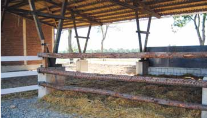
Im überdachten Teil des Bewegungsstalls können die Pferde wahlweise auf Stroh oder Sand liegen.
